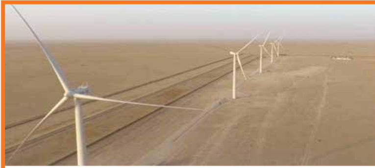
الشكل (5 - 3): الشقاي (المرحلة الأولى) 10 ميغاواط، إجمالي 5 توربينات رياح كل منها 2 ميغاواط
