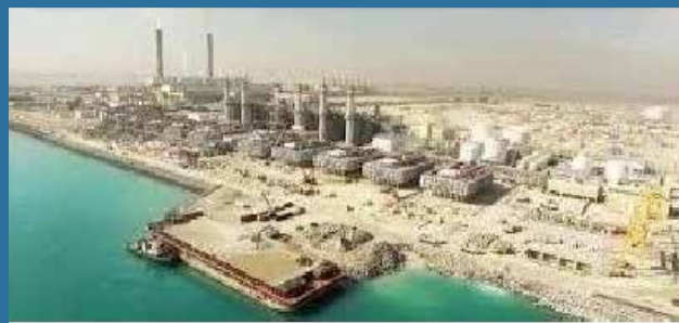
الشكل 1 - 10: محطة كهرباء وتحلية الزور الشمالية المستقلة، تم إنشاؤها عام 2006
